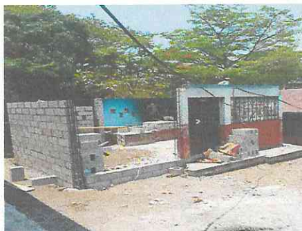
Foto 6: Levantado de paredes de cocina
