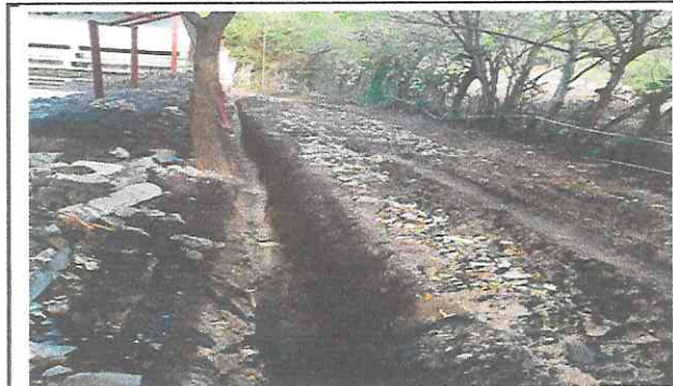
Foto 1: Cimiento de muro perimetral
