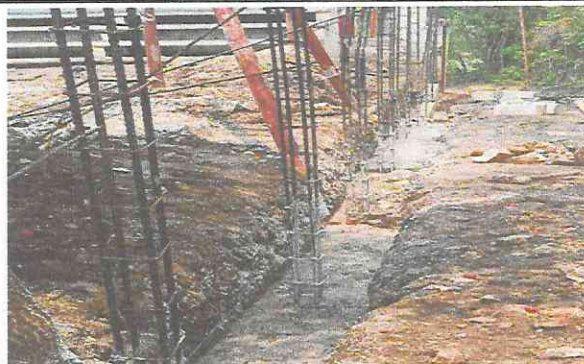
Foto 2: Fundición de muro perimetral
