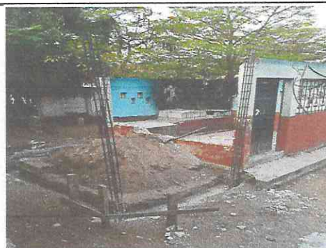
Foto 4: Ampliación de cocina
