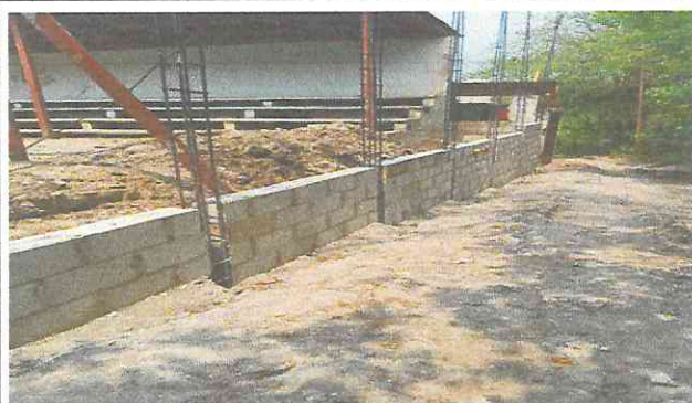
Foto 3: Levantado de muro perimetral
