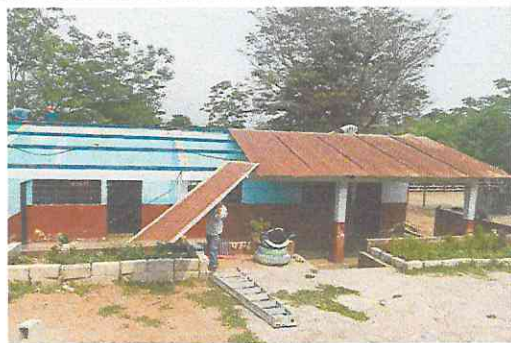
Foto 5: Cambio de techo de aula
